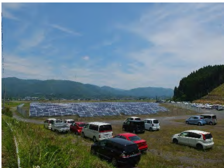
未利用地に設置されたソーラーパネル
