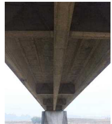
PC橋（前田橋（T桁橋））
