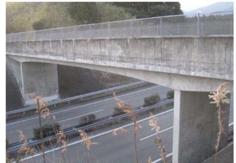
ラーメン橋 (吹ヶ迫橋)
