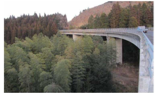
支間長 60m の白鳥大橋 (PC 箱桁橋)
