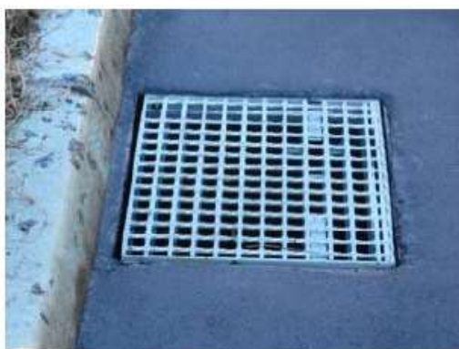
（例）グレーチング蓋の格子の形状を工夫した事例
