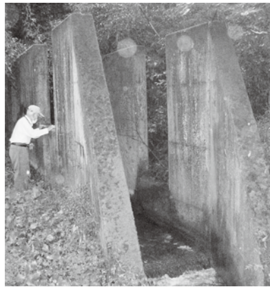
霧島演習場廠舎周辺排水が岡元用水路に
