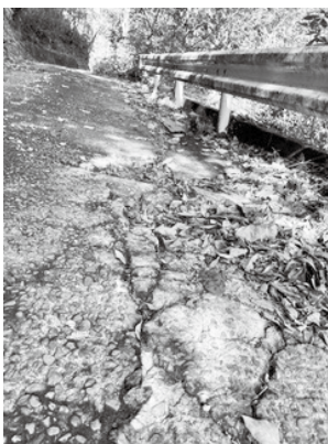
市道32号線後平山神線の現状
