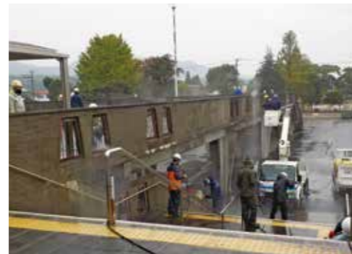
高所作業車や高圧洗浄機を使って清掃
