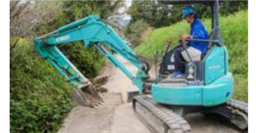
水道工事現場でのコンボによる掘削作業
