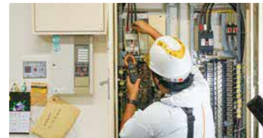
電圧・漏電の確認や照明・空調の点検・清掃を実施
