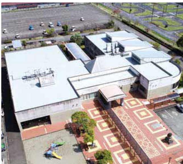
改修工事が完了した市民図書館・市歴史民俗資料館
