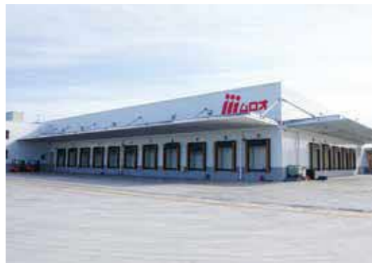
完成したえびの産業団地第2低温物流センター
