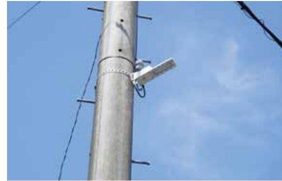
自治会加入者の要望をもとに、安全のため防犯灯を設置しました（中原田自治会）
